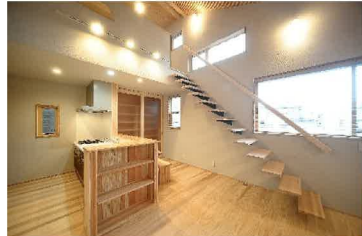
ブナ材を使った階段施工事例
